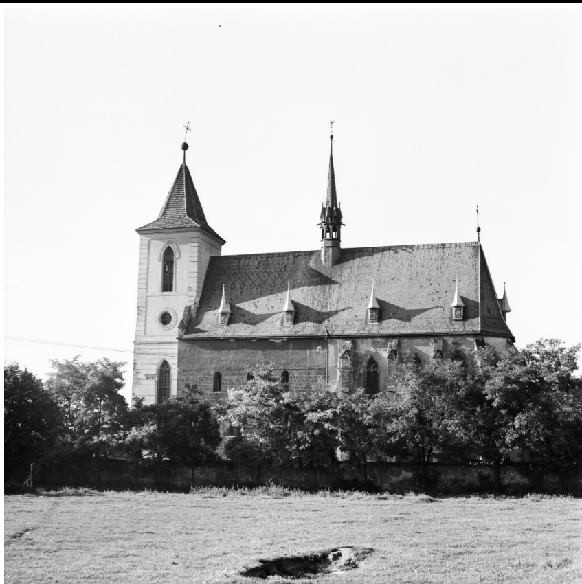
Celkový pohled od jihu. Foto: 1966, sbírka negativů NPÚ ÚOP v Ústí n. L., sign. 26527.
