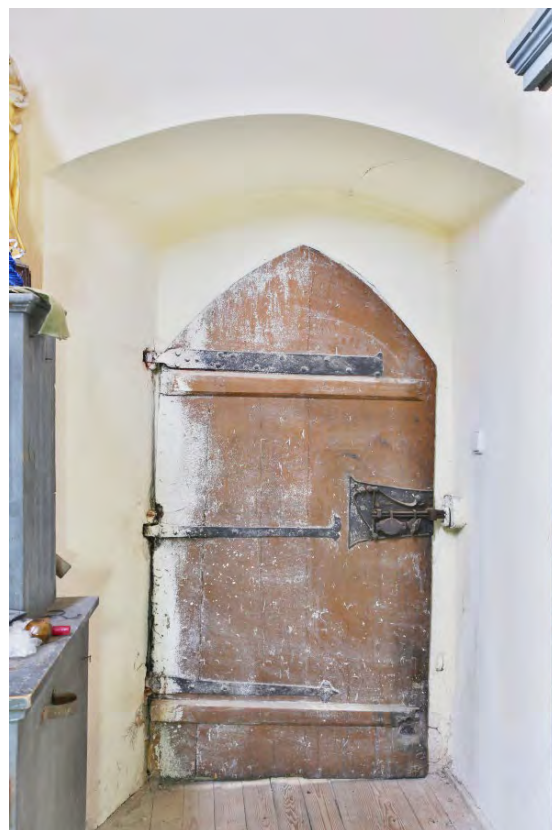
Jižní vstupní otvor sakristie směřující do presbytáře. Foto: Kateřina Neumannová, 2015.
