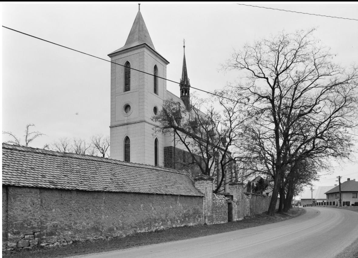
Pohled od jihozápadu. Foto: 1995, sbírka negativů NPÚ ÚOP v Ústí n. L., sign. 110322.
