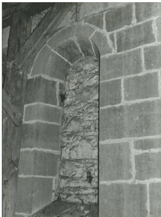
Východní románský okenní otvor severní strany lodi v pohledu z podkroví boční lodi/kaple. Foto:1976–1977. Zdroj: Vlastimil ŠAFRÁNEK, Kostel sv. Jakuba Většího ve Slavětíně, stavebně historický průzkum, fotodokumentace , foto č. 62.
