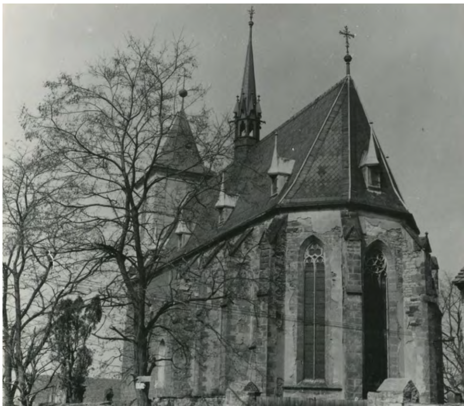
Pohled od jihovýchodu. Foto: 1976. Zdroj: Karel KRÁL, Kostel sv. Jakuba ve Slavětíně, stavebně historický průzkum , 1976, foto č. 5.
