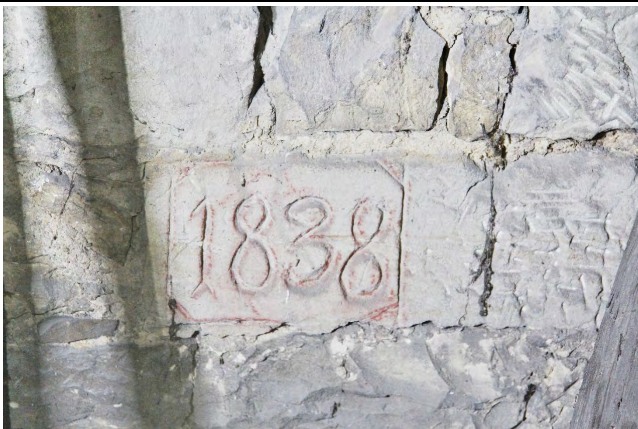
Letopočet 1838 na kvádru vnějšího líce zdiva věže obracejícího se směrem do krovu. Foto: Jaroslav Skopec, 2019.
