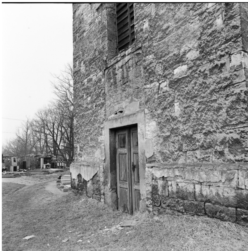
Spodní úroveň západního průčelí věže v pohledu od jihozápadu. Foto: 1979, sbírka negativů NPÚ ÚOP v Ústí n. L., sign. 61238.
