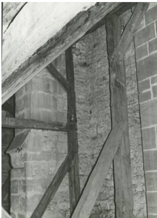
ZPrvní severní opěrák presbytáře ve směru od západu v pohledu z podkrovní boční lodi/kaple. Foto:1976–1977. Zdroj: Vlastimil ŠAFRÁNEK, Kostel sv. Jakuba Většího ve Slavětíně, stavebně historický průzkum, fotodokumentace , foto č. 64.
