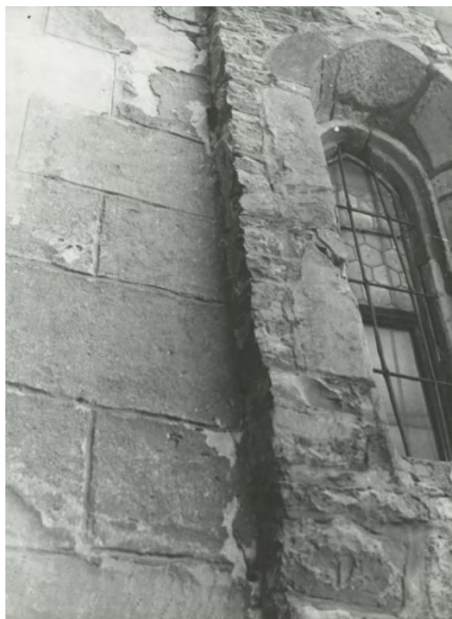
Styk východního zdiva sakristie a severního opěráku presbytáře. V záklenku východního okenního otvoru sakristie je patrná jeho úprava. Foto:1976–1977. Zdroj: Vlastimil ŠAFRÁNEK, Kostel sv. Jakuba Většího ve Slavětíně, stavebně historický průzkum, fotodokumentace , foto č. 5.
