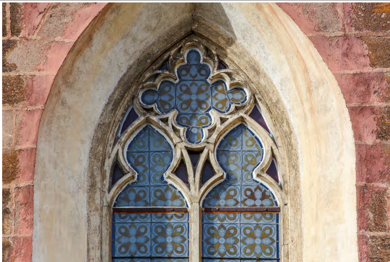
Kružba západního okenního otvoru jižního průčelí lodi. Foto: Kateřina Neumannová, 2015.
