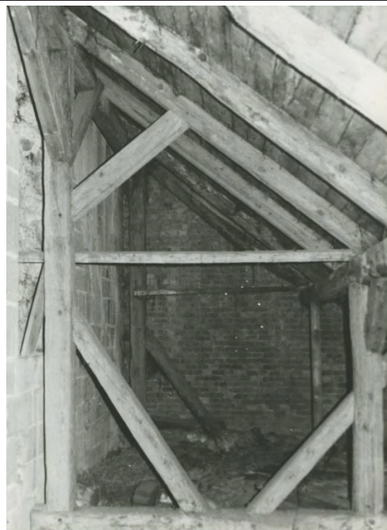
Průhled krovem nad boční lodí/kaplí ve směru od východu. Foto:1976–1977. Zdroj: Vlastimil ŠAFRÁNEK, Kostel sv. Jakuba Většího ve Slavětíně, stavebně historický průzkum, fotodokumentace, foto č. 59.
