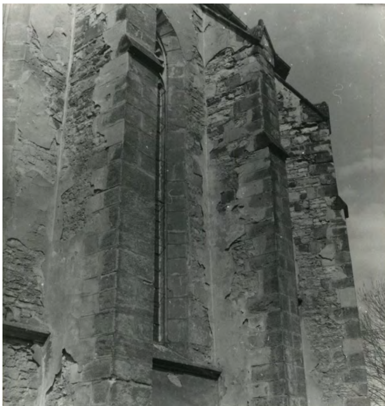
Opěráky jižního průčelí presbytáře v pohledu od jihozápadu. Foto: 1976. Zdroj: Karel KRÁL, Kostel sv. Jakuba ve Slavětíně, stavebně historický průzkum , 1976, foto č. 9.
