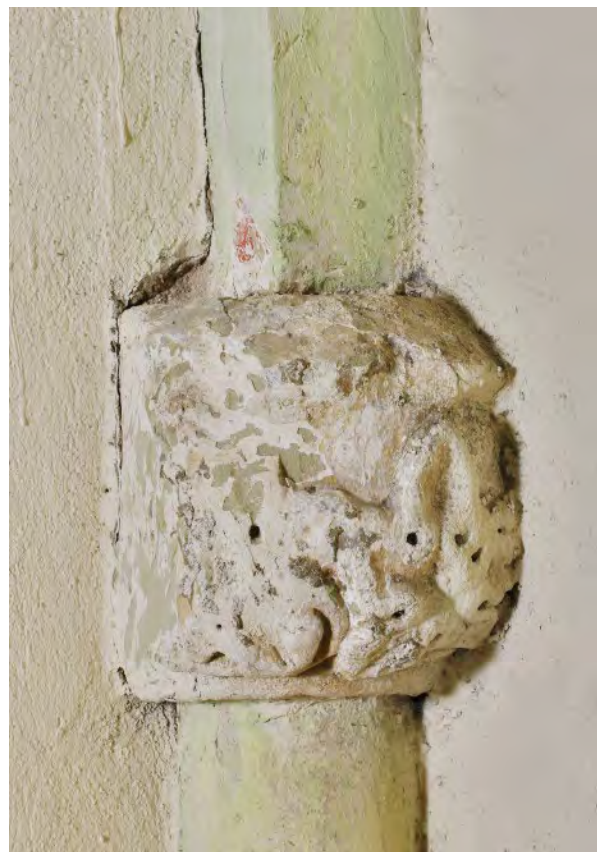
Hlavice zkrácené přípory v severozápadním koutu boční lodi/kaple. Foto: Kateřina Neumannová, 2015.
