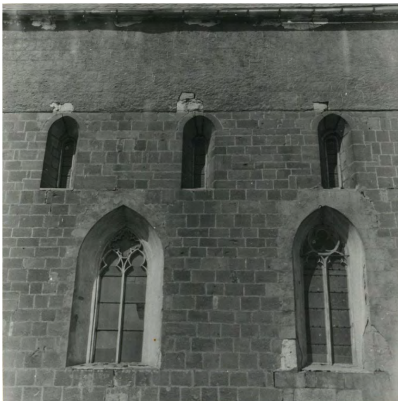
Horní partie jižního průčelí presbytáře. Foto: 1976. Zdroj: Karel KRÁL, Kostel sv. Jakuba ve Slavětíně, stavebně historický průzkum , 1976, foto č. 7.
