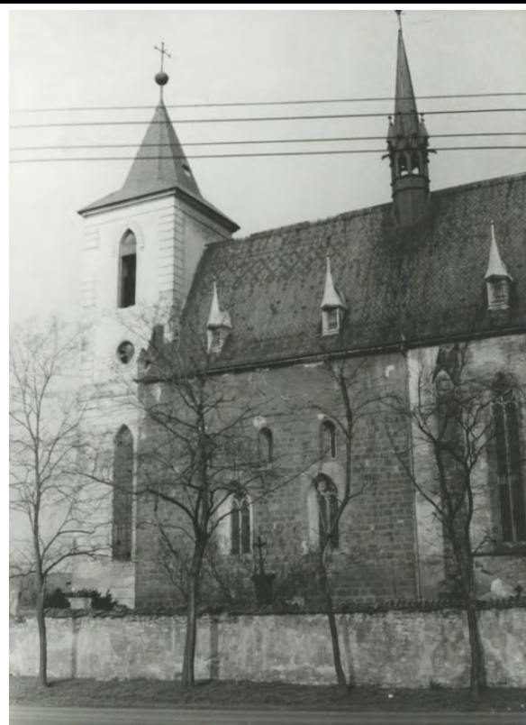
Západní polovina jižního průčelí. Foto:1976–1977. Zdroj: Vlastimil ŠAFRÁNEK, Kostel sv. Jakuba Většího ve Slavětíně, stavebně historický průzkum, fotodokumentace, foto č. 3.
