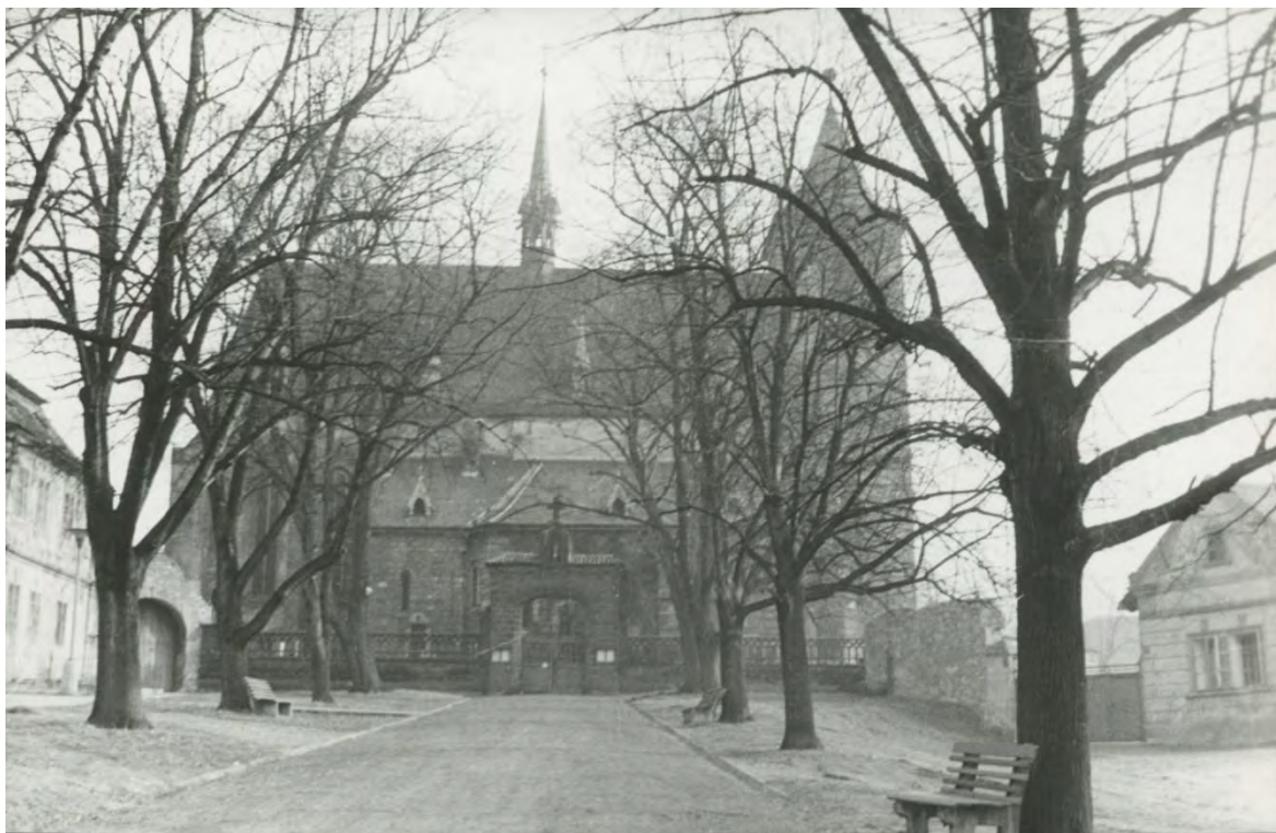
Celkový pohled od jihu. Foto:1976–1977. Zdroj: Vlastimil ŠAFRÁNEK, Kostel sv. Jakuba Většího ve Slavětíně, stavebně historický průzkum, fotodokumentace, foto č. 2.
