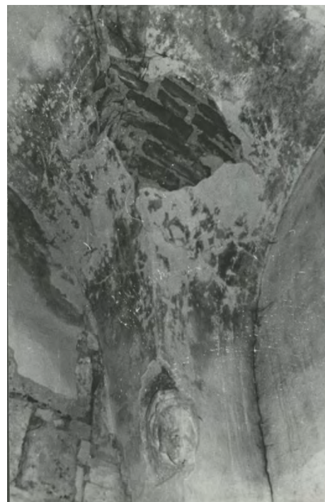
Severozápadní příložka s patou klenby sakristie v pohledu od jihovýchodu. Foto:1976–1977. Zdroj: Vlastimil ŠAFRÁNEK, Kostel sv. Jakuba Většího ve Slavětíně, stavebně historický průzkum, fotodokumentace , foto č. 26.
