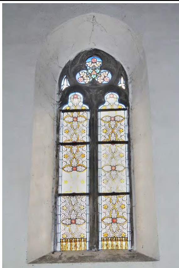
Východní okenní otvor jižní strany lodi. Foto Jaroslav Skopec, 2019.
