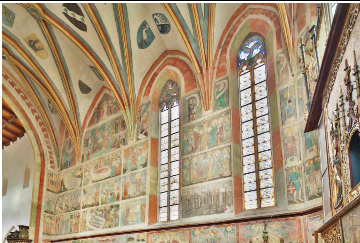
Severní strana presbytáře v pohledu od jihovýchodu. Foto: Kateřina Neumannová, 2015.
