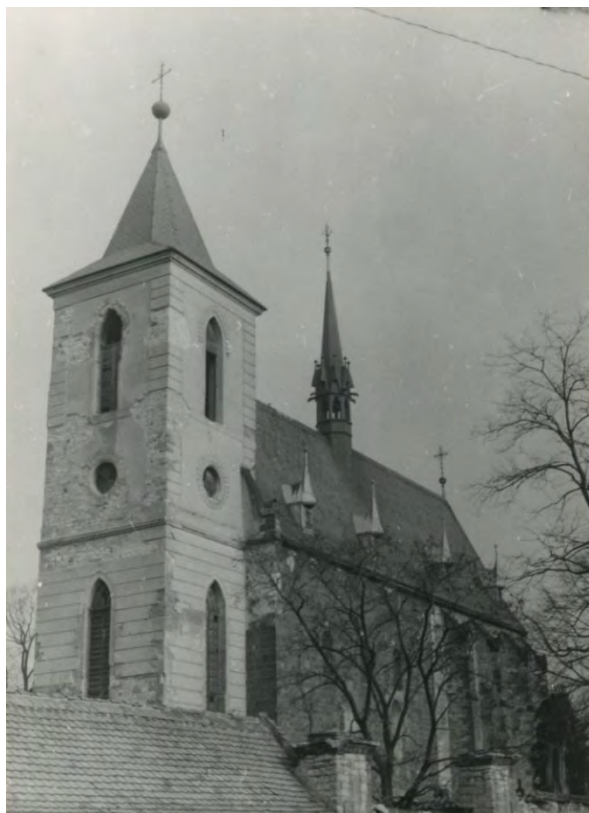
Pohled od jihozápadu. Foto: 1976. Zdroj: Karel KRÁL, Kostel sv. Jakuba ve Slavětíně, stavebně historický průzkum , 1976, foto č. 3.
