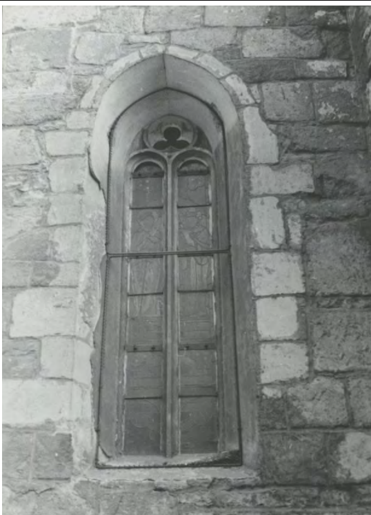
Severní okenní otvor závěru boční lodi/kaple. Foto:1976–1977. Zdroj: Vlastimil ŠAFRÁNEK, Kostel sv. Jakuba Většího ve Slavětíně, stavebně historický průzkum, fotodokumentace , foto č. 10.
