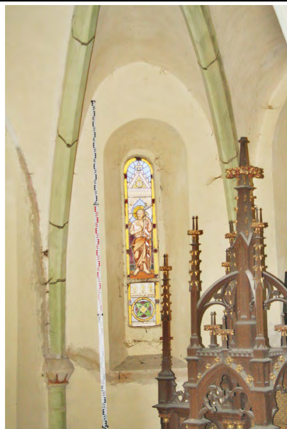
Severovýchodní okenní otvor závěru boční lodi/kaple. Foto Jaroslav Skopec, 2015.
