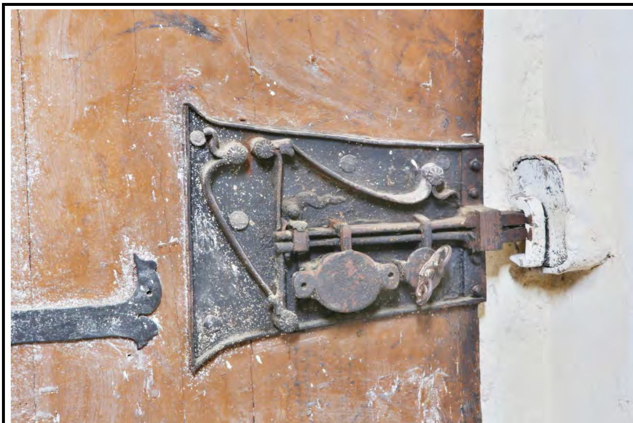
Zámek dveří vstupu z presbytáře do sakristie. Foto: Kateřina Neumannová, 2015.
