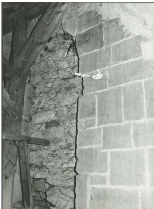
Západní románský okenní otvor severní strany lodi v pohledu z podkroví boční lodi/kaple. Foto:1976–1977. Zdroj: Vlastimil ŠAFRÁNEK, Kostel sv. Jakuba Většího ve Slavětíně, stavebně historický průzkum, fotodokumentace , foto č. 60.
