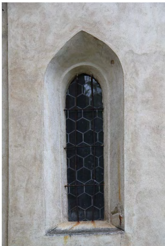
Východní okenní otvor sakristie. Foto Jaroslav Skopec, 2019.
