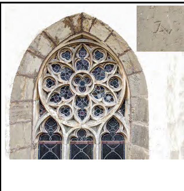
Kružba jižního okenního otvoru závěru presbytáře a detail kamenické značky na západní špaletě. Foto: Petr Hasil, 2021.
