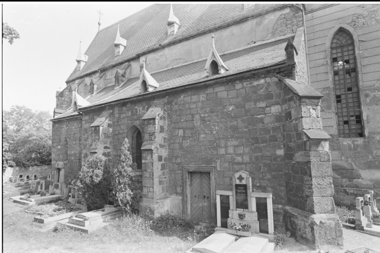
Severní průčelí boční lodi/kaple v pohledu od severozápadu. Foto: 1975, sbírka negativů NPÚ ÚOP v Ústí n. L., sign. 53091.
