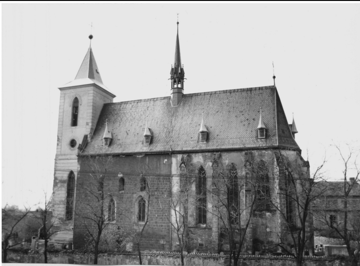
Celkový pohled od jihu. Foto: 1973, sbírka negativů NPÚ GŘ, sign. N110281.
