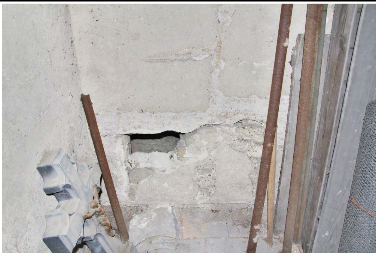
Zazděný románský vstup v západním zdivu lodi v pohledu od západu z druhého patra věže. Foto: Jaroslav Skopec, 2019.
