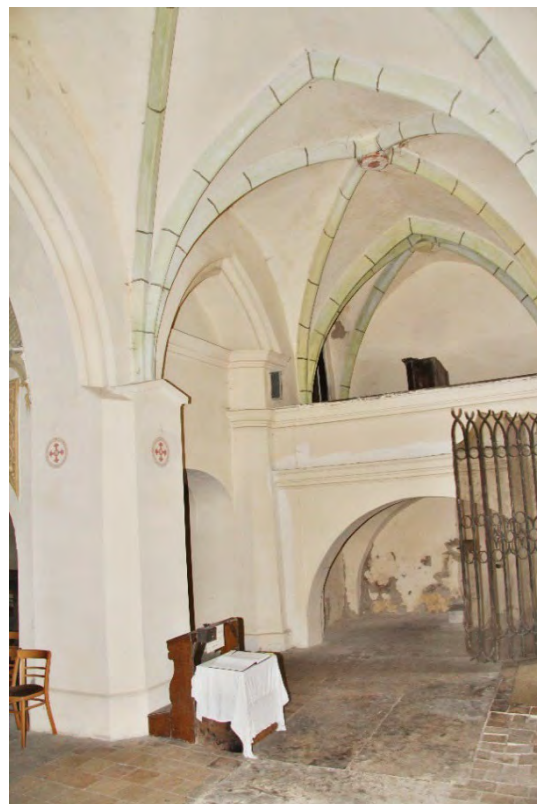
Interiér boční lodi/kaple v pohledu od severovýchodu. Foto Jaroslav Skopec, 2019.
