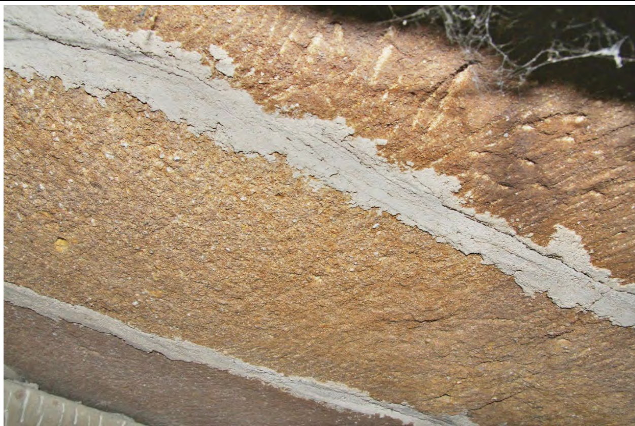
Překlad zazděného románského vstupu v západním zdivu lodi. Foto: Jaroslav Skopec, 2019.
