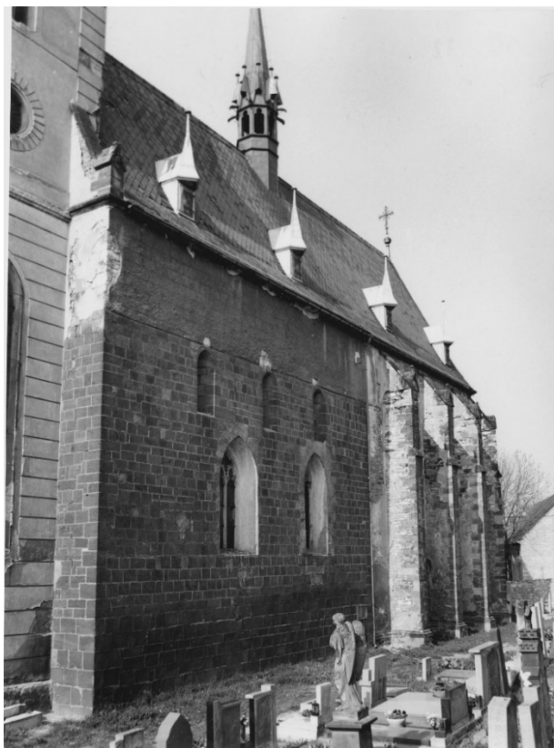
Jižní průčelí v pohledu od jihozápadu. Foto: 1973, sbírka negativů NPÚ GŘ, sign. N110282.
