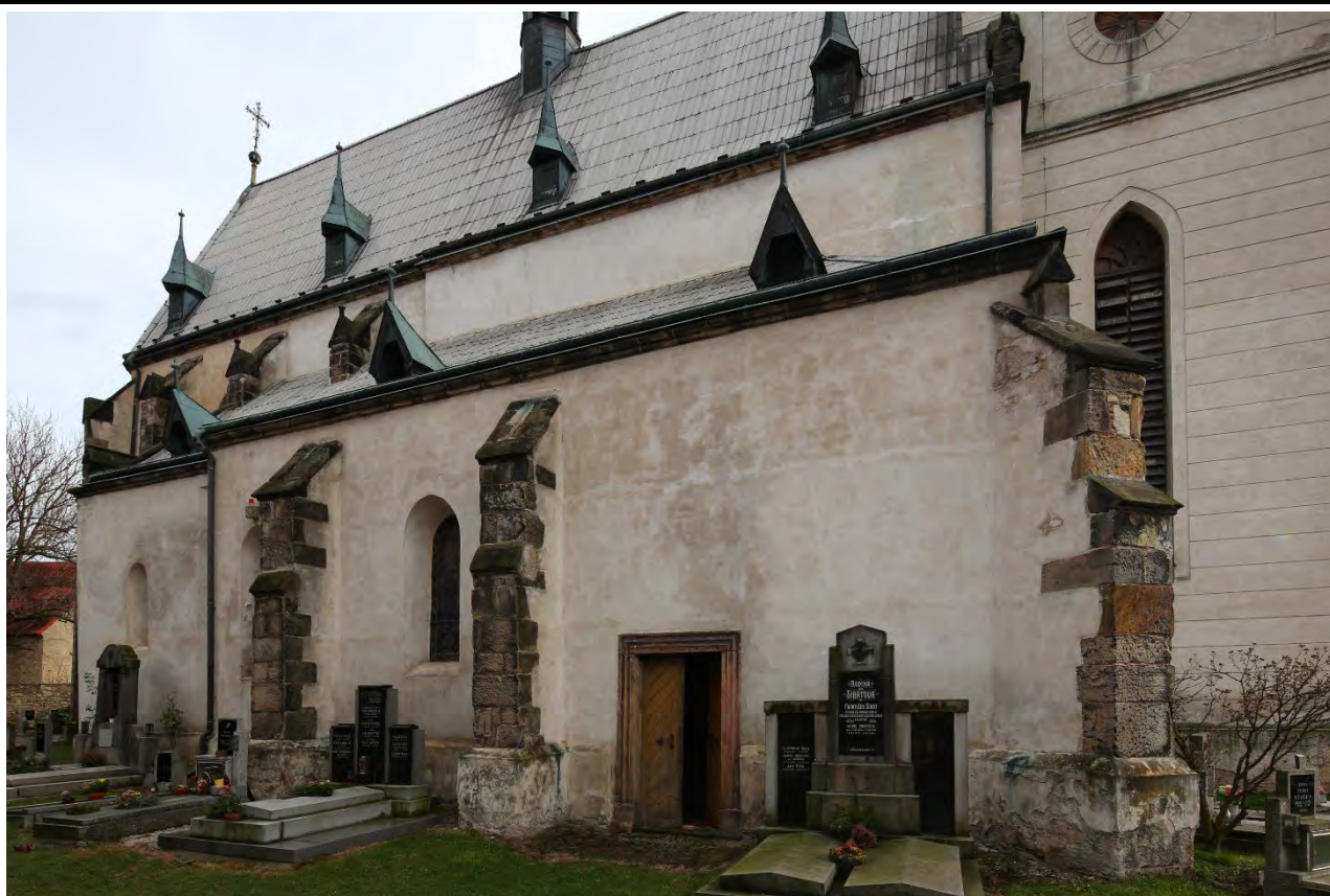
Severní průčelí lodi v pohledu od severozápadu. Foto: Kateřina Neumannová, 2015.
