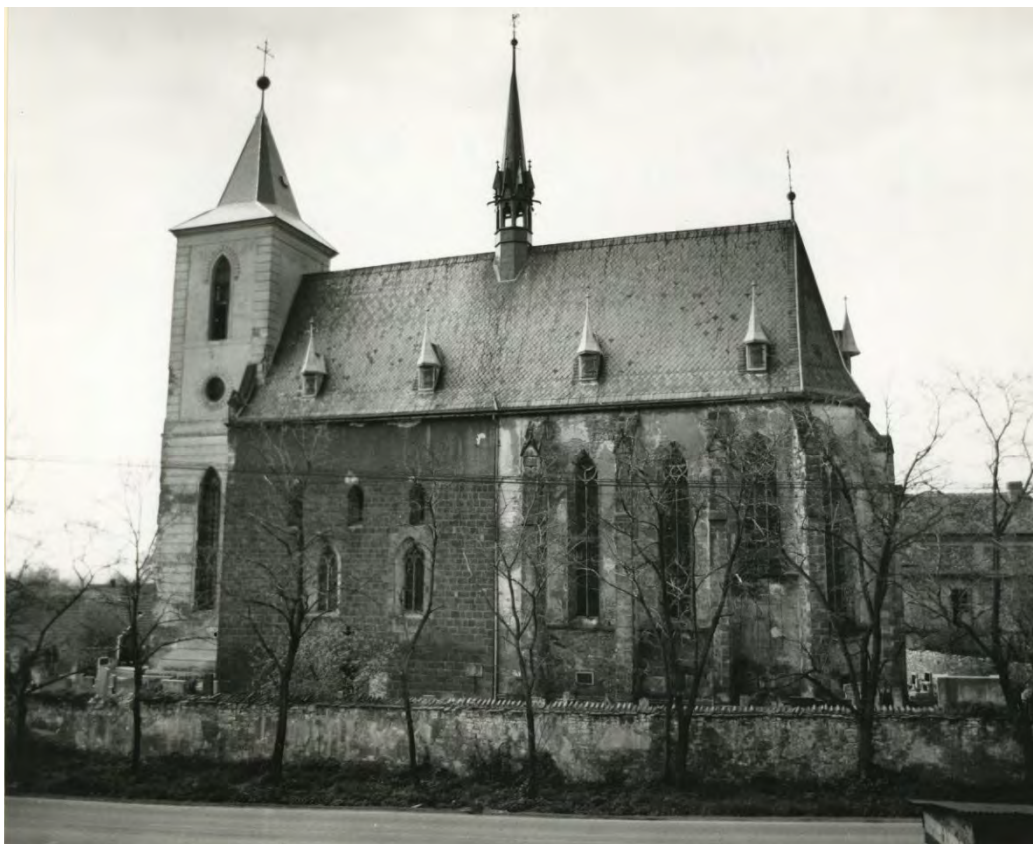
Celkový pohled od jihu. Foto: 1976. Zdroj: Karel KRÁL, Kostel sv. Jakuba ve Slavětíně, stavebně historický průzkum, 1976, foto č. 2.
