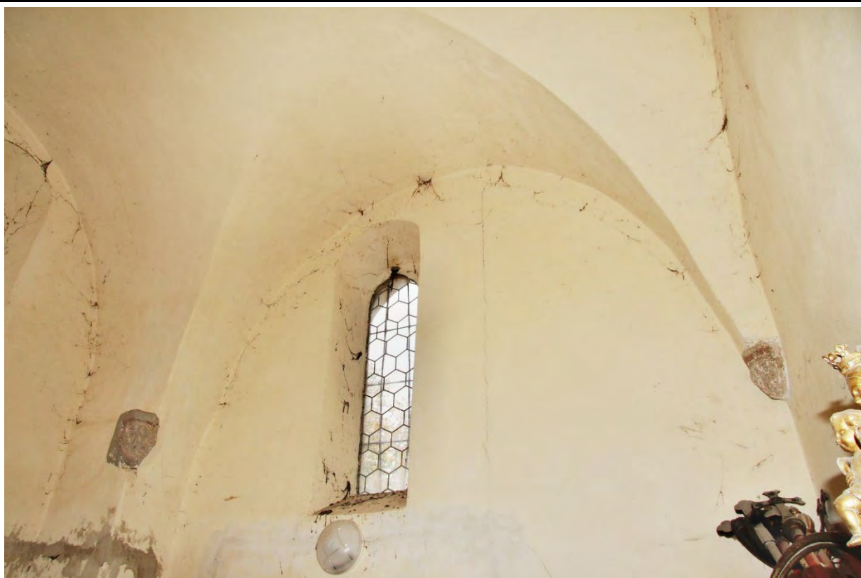
Horní polovina východní strany sakristie. Po pravé straně okenního otvoru je patrná vertikální spára mezi východním zdivem sakristie a opěrákem presbytáře. Foto: Jaroslav Skopec, 2019.
