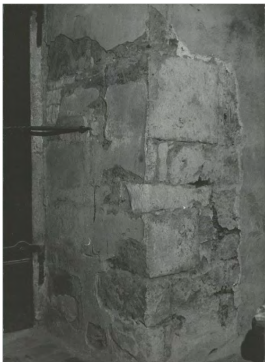
Severní špaleta niky vstupu z hlavní lodi do podvěží v pohledu od jihovýchodu. Foto:1976–1977. Zdroj: Vlastimil ŠAFRÁNEK, Kostel sv. Jakuba Většího ve Slavětíně, stavebně historický průzkum, fotodokumentace , foto č. 39.
