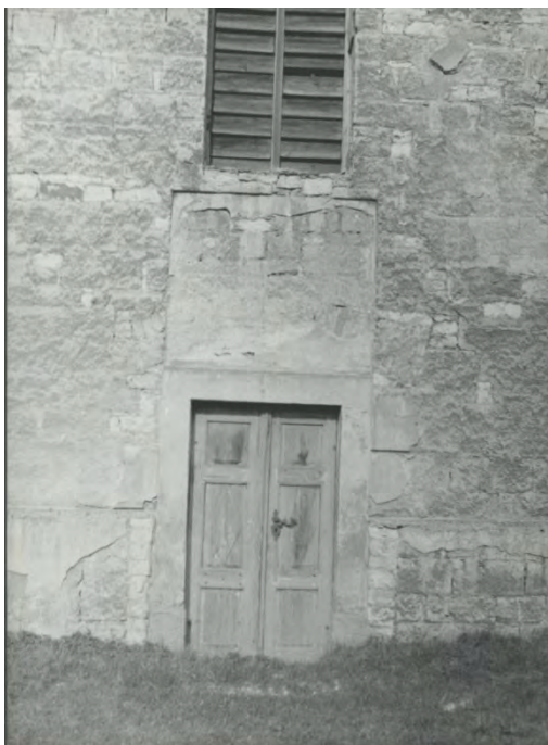
Spodní úroveň západního průčelí věže. Foto:1976–1977. Zdroj: Vlastimil ŠAFRÁNEK, Kostel sv. Jakuba Většího ve Slavětíně, stavebně historický průzkum, fotodokumentace, foto č. 71.
