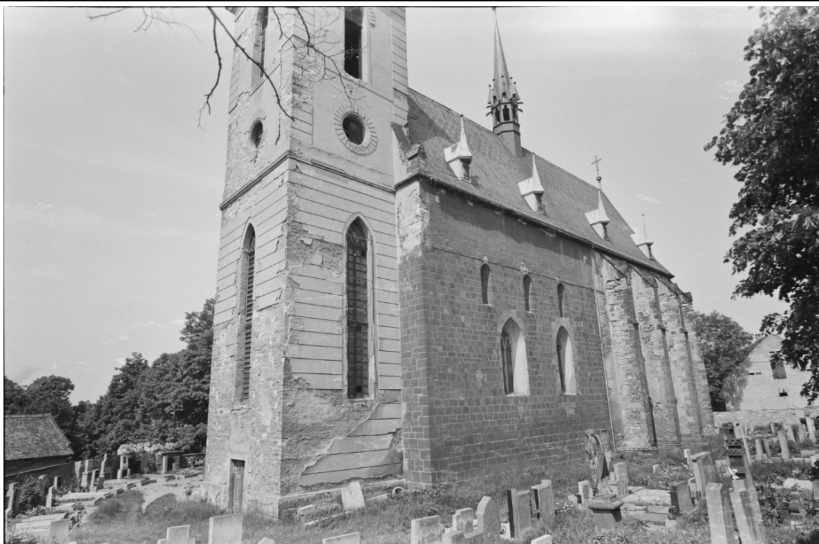
Jižní průčelí kostela v pohledu od jihozápadu. Foto: 1975, sbírka negativů NPÚ ÚOP v Ústí n. L., sign. 53090.
