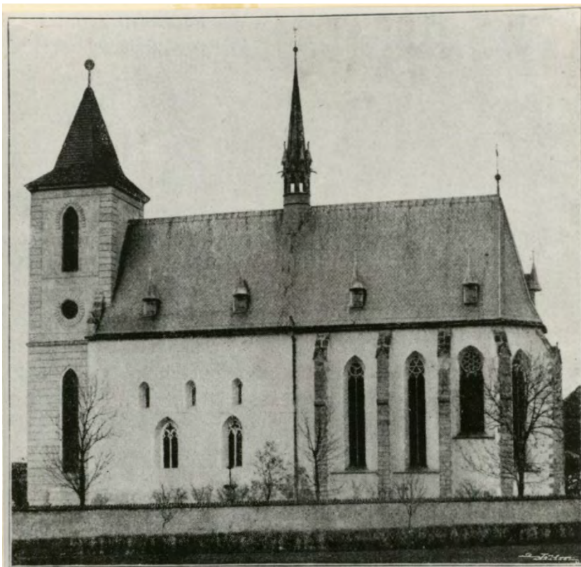
Pohled od jihu. Foto: konec 19. století. Zdroj: Karel KRÁL, Kostel sv. Jakuba ve Slavětíně, stavebně historický průzkum , 1976, foto č. 50.
