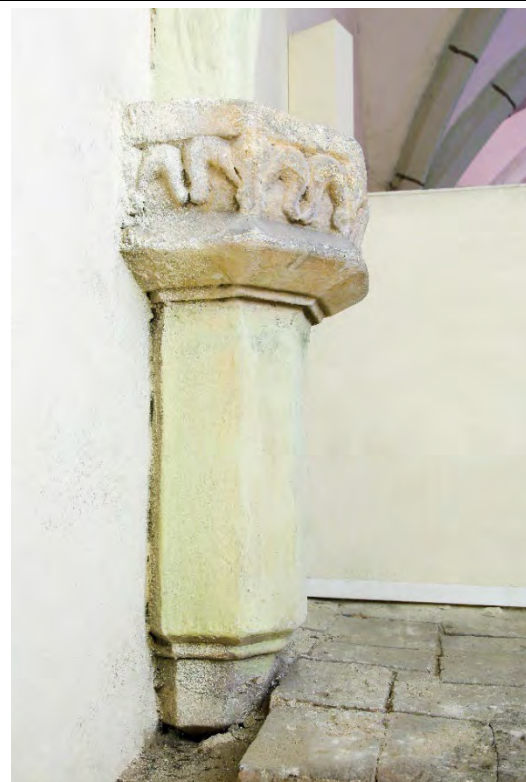
Severní zkrácená přípora boční lodi/kaple na rozhraní západního obdélného pole a západního pole čtvercového. Foto: Kateřina Neumannová, 2015.
