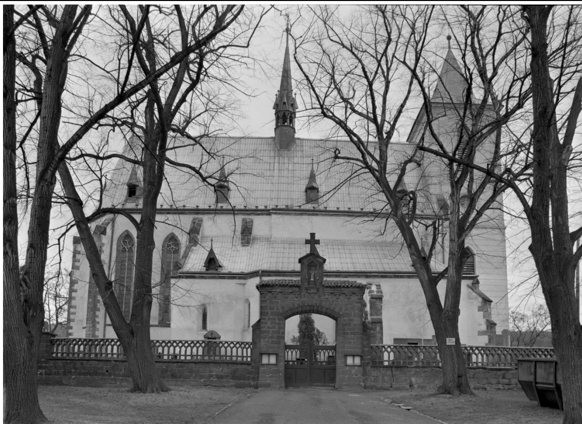
Celkový pohled od severu. Foto: 1995, sbírka negativů NPÚ ÚOP v Ústí n. L., sign. 110324.
