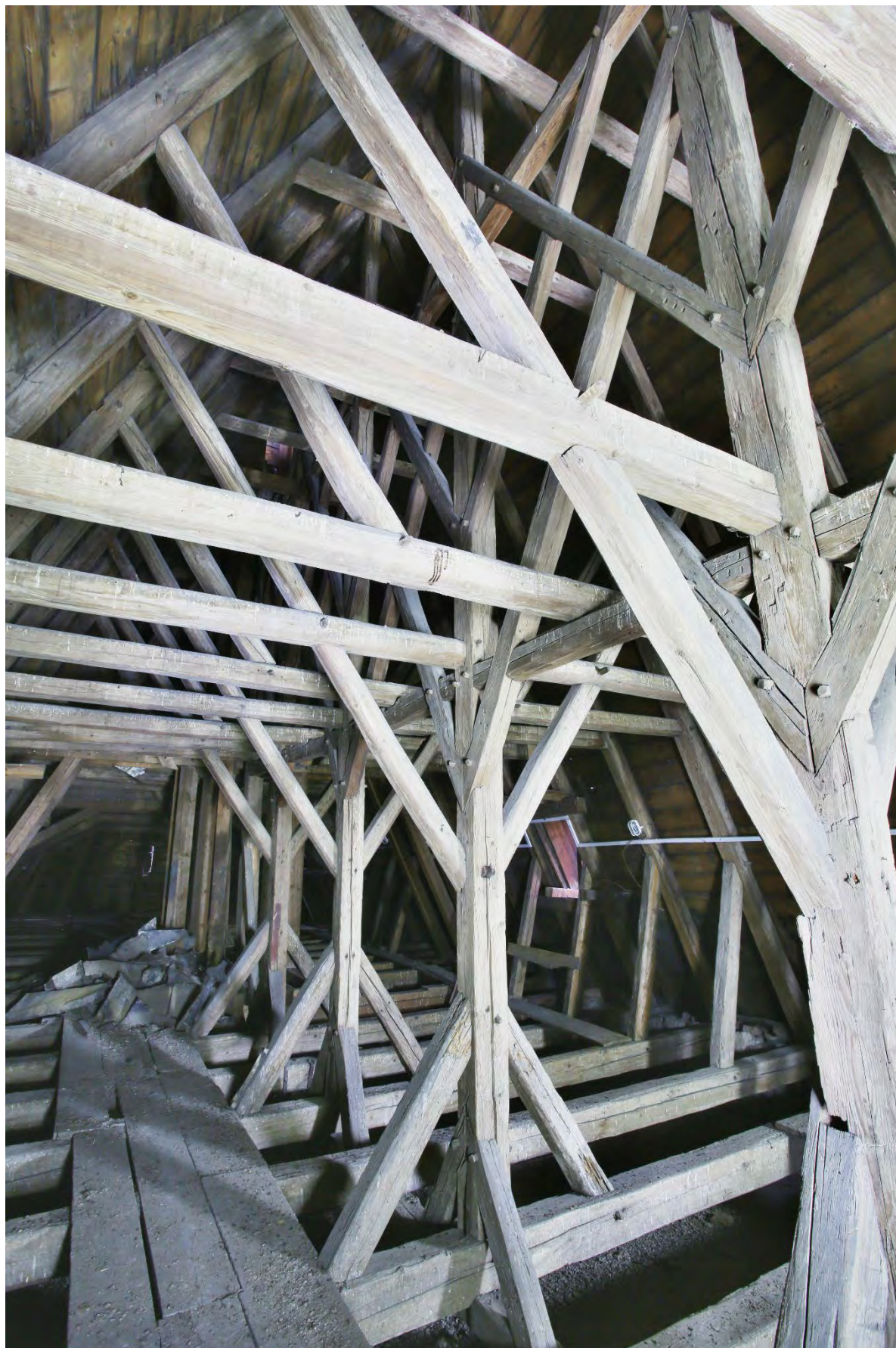
Průhled krovem nad lodí ve směru k východu. Foto: Kateřina Neumannová, 2015.
