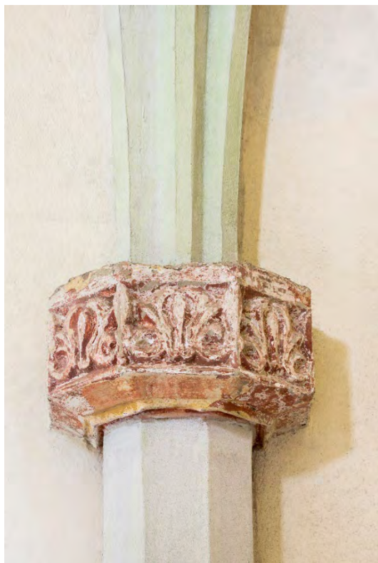
Hlavice severní přípory na rozhraní východního čtvercového klenebního pole a pole závěru. Foto: Kateřina Neumannová, 2015.
