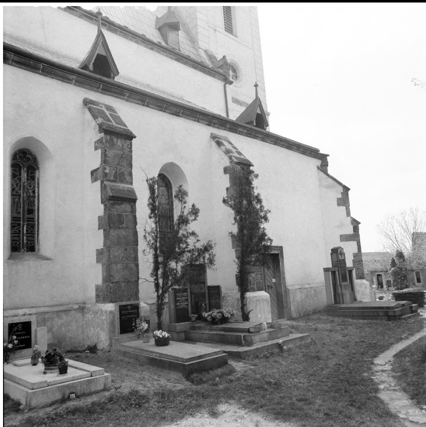
Severní průčelí boční lodi v pohledu od severovýchodu. Foto: 1988, sbírka negativů NPÚ ÚOP v Ústí n. L., sign. 96397.
