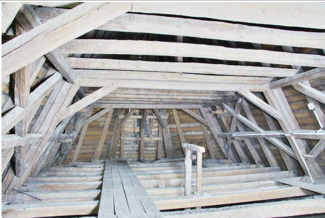
Průhled krovem nad presbytářem ve směru k východu. Foto: Jaroslav Skopec, 2019.
